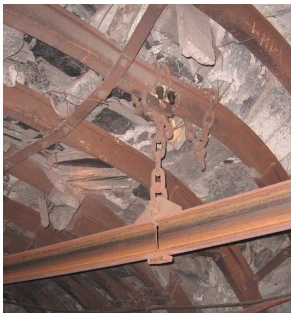
Рисунок 2 – Деформації порід навколо підготовчої виробки в умовах шахти ім. Стаханова
